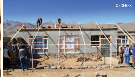
Construction d'une véranda en métal à Behsud
