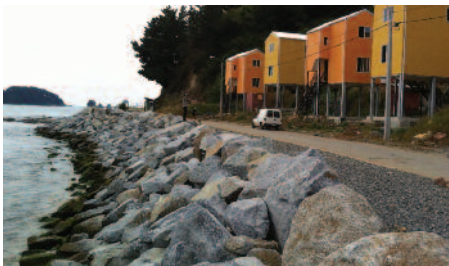
Maisons construites pour résister aux catastrophes naturelles
