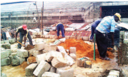
Construction d'un biocentre
