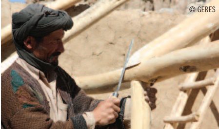
Formation d'un menuisier sur la construction d'une véranda
