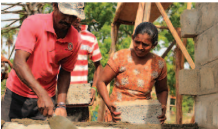
Construction de murs à Mullaitivu
