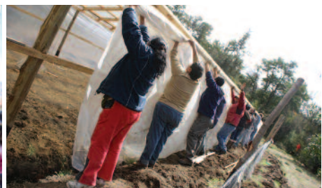
Des membres de la communauté construisant des logements
