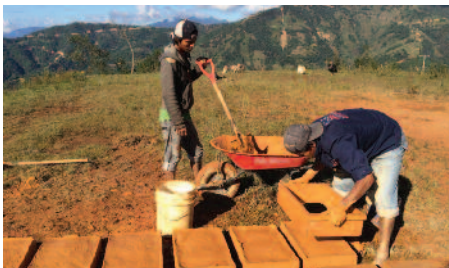
Utilisation de matériaux locaux pour les constructions
