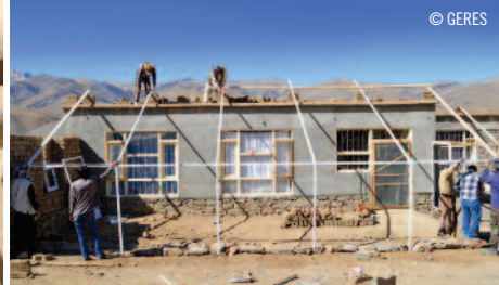
Construyendo un kit de galería de metal en Behsud
