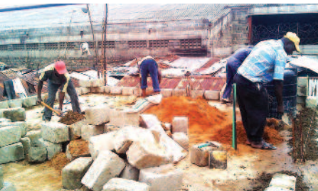
Construcción de un bio-centro
