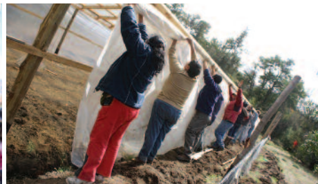
Miembros de la comunidad construyendo vivienda
