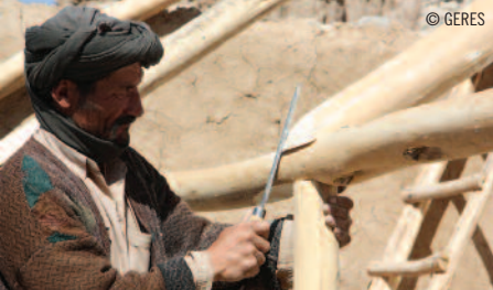
Capacitando a un carpintero en la construcción de galerías
