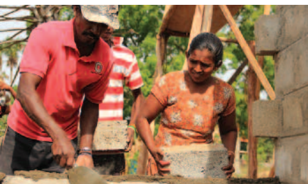
Construcción de muros en progreso en Mullaitivu
