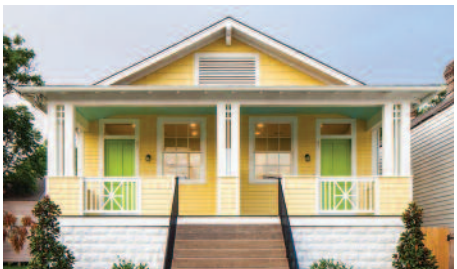
Luego de la restauración y renovación, lista para los nuevos residentes
