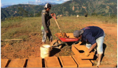
Utilización de materiales locales para la construcción
