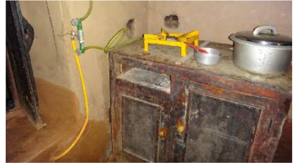
Estufa y tuberías conectadas al sistema de biogás
