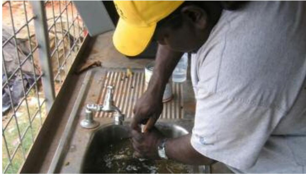
Arreglando un bloqueo en el canal de aguas servidas
