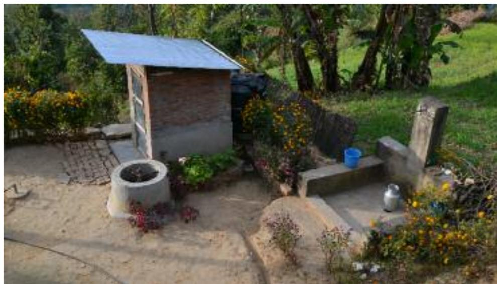
Un sistema de desecho integrado: baño, tanque de almacenamiento de agua lluvia, tanque séptico, digester de biogás
