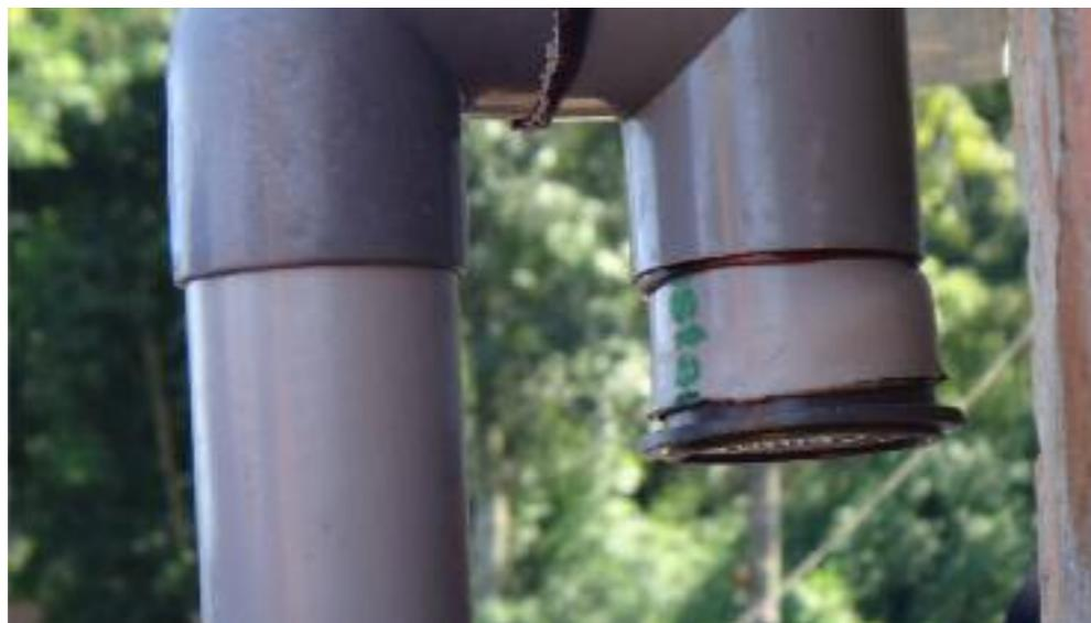
Tubería conectada al techo para recoger y almacenar el agua de escorrentía
